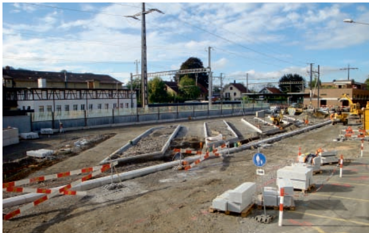
Der neue Bushof im Bau. Ab 9. Dezember 2012 ist er in Betrieb.
